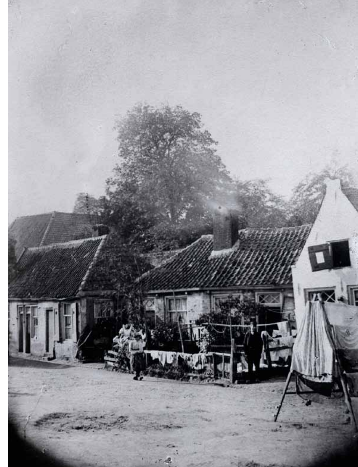
] krotwoning op het Prinsenhof, tegenwoordig het Hagepoortplein, 1923
